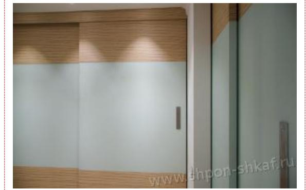
Раздвижные перегородки в едином стиле с дверями шкафа-купе, отделяют спальню от остального пространства квартиры. Подобные перегородки могут быть выполнены и без верхней декоративной планки, если крепить направляющую к бетонному потолку, выше гипсокартонного (в этом случае будет видна только щель в 3,5 сантиметра).
