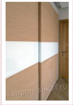
В стекле же прямоугольный стык обеспечивается использованием **2 стекол с фазетом 45 градусов** (т.е. узкое боковое стекло не просто обработано по кромке обычной "трапецией" и приставлено к фасадному)!
